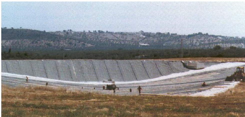
Figura 50: Operazioni di posa del telo impermeabile per la realizzazione di uno dei due laghetti collinari
