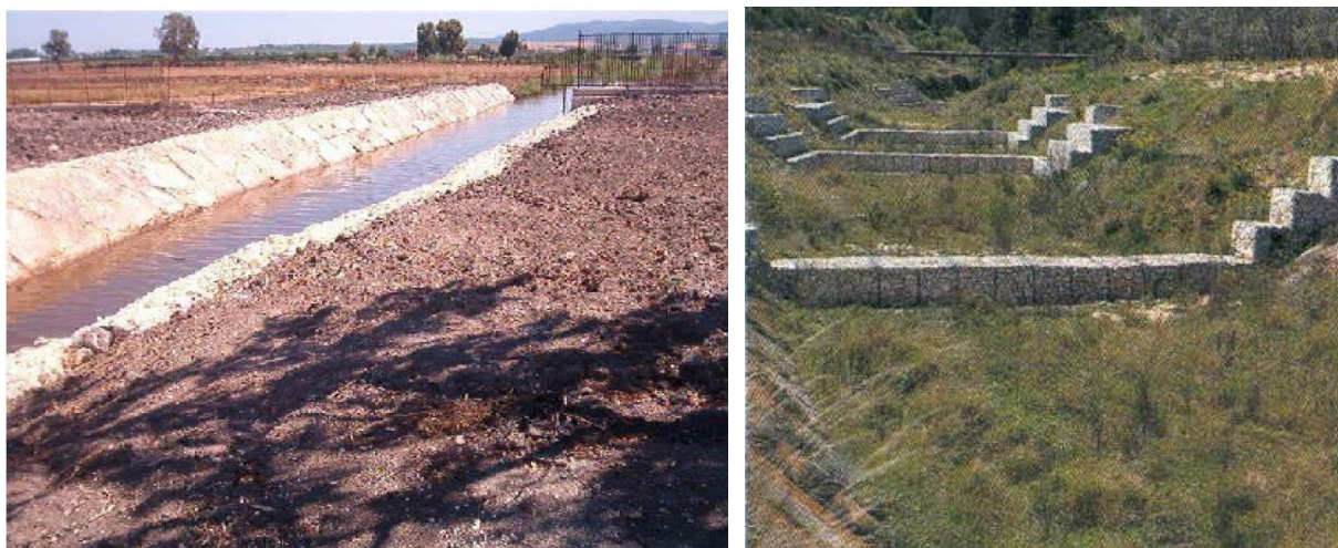
Figura 46: Canale rivestito (a destra) e salti di fondo (a sinistra) realizzati dal Consorzio
