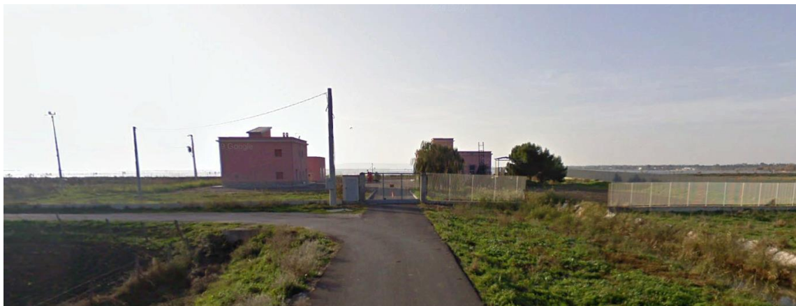
Figura 51: Impianto idrovoro di Muschiatturo
